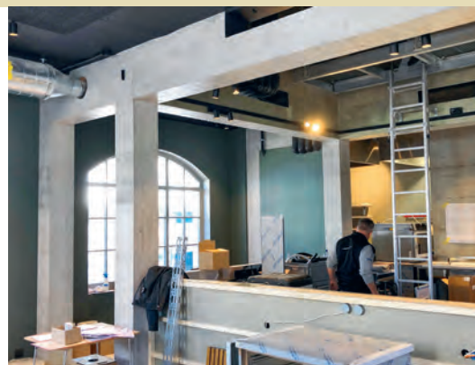
Noch ist Bauphase beim Tramhüsli.
