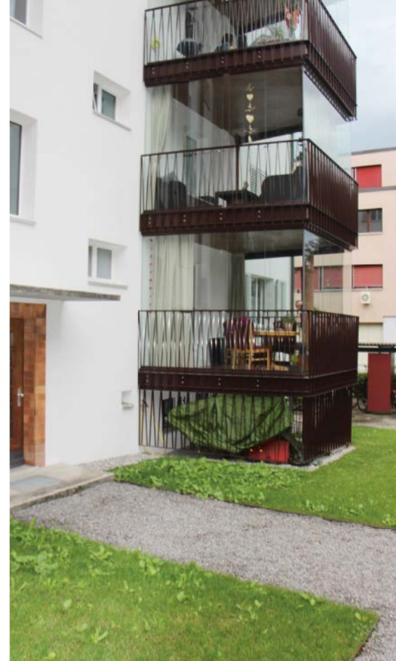
Sanierung Weinberglistrasse: ein Paradebeispiel für die heutige Baukunst.
