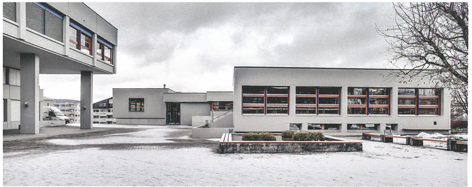
Aussenansicht Trakt A, B und C
